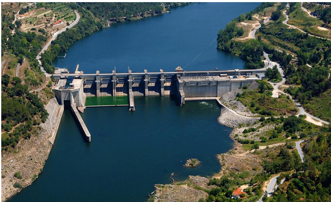
Figura 65 | Barragem do Carrapatelo
