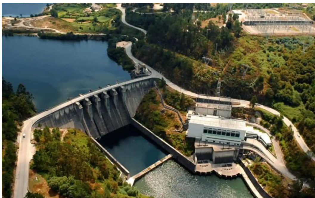
Figura 67 | Barragem do Torrão
